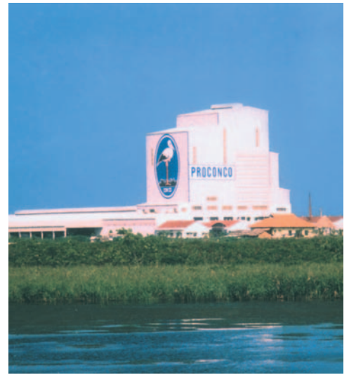
Usine de Dinh Vu (Hai Phong).
